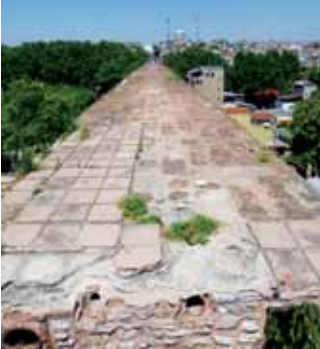
Fotoğraf 26. Atatürk Caddesi üzerinde kemerin son restorasyonda yapılan kaplaması ve farklı dönemlere ait eski suyollarının izleri.
