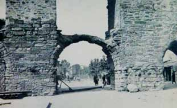
Fotoğraf 10. İtfaiye Caddesi yönünde taş kemere eklenen tuğla kemer yıkılmadan önce.
