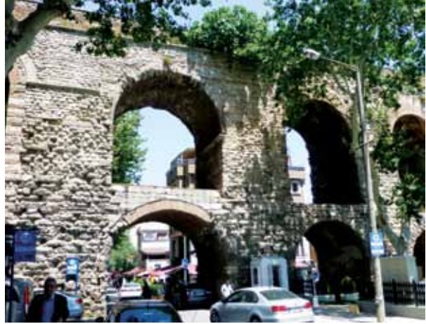
Fotoğraf 14. Aynı alanın bugünkü durumu, taş odayı oluşturan duvarlar kaldırılmış.
