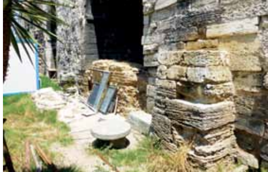
Fotoğraf 27. Osmanlı döneminde yeniden inşa edilen kemerin altında tuğla hazne izi.
